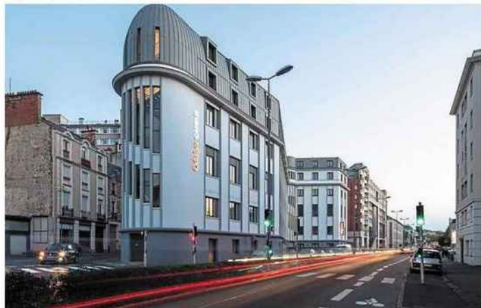
Vue de la résidence Courboulay du Mans avec son nouvel étage finalisé. | PHOTO : DR
